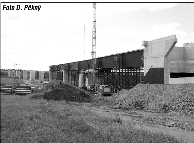
Nový železniční most (přemostění dálnice D3)
