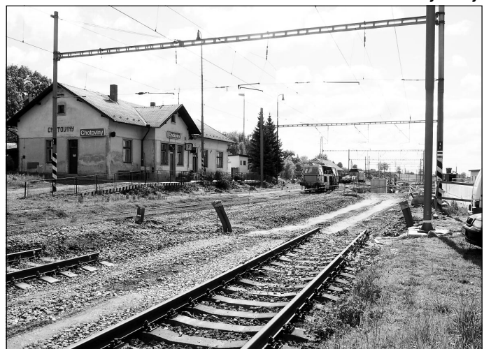
Stavební práce pod kolejí č. 1 a 3
